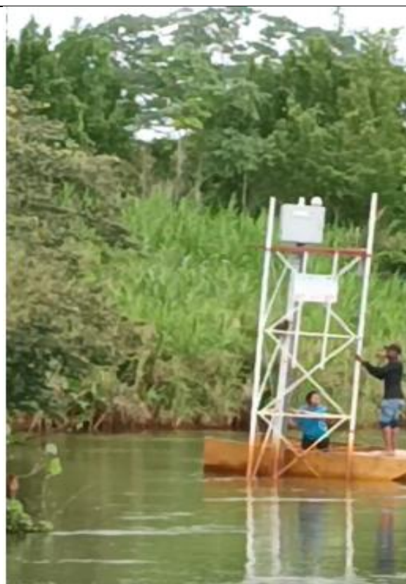
Foto 2 : inspectie van de stellatie (Brokopondo)
