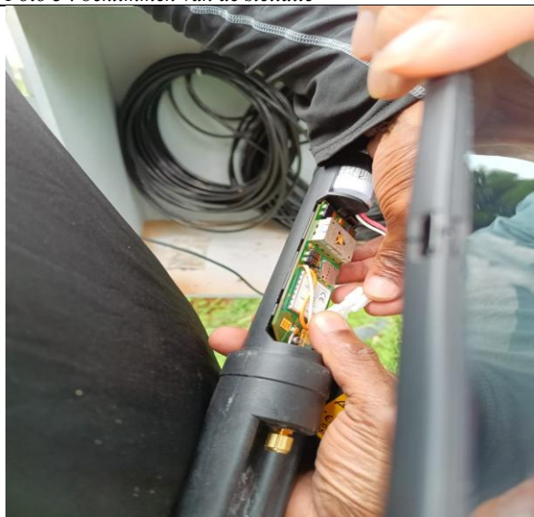
Foto 5: verwisselen van de batterij (Ston-eiland)
